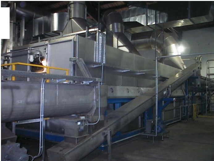
그림 7: 벨트건조기로 Digestate를 건조시키는 모습
